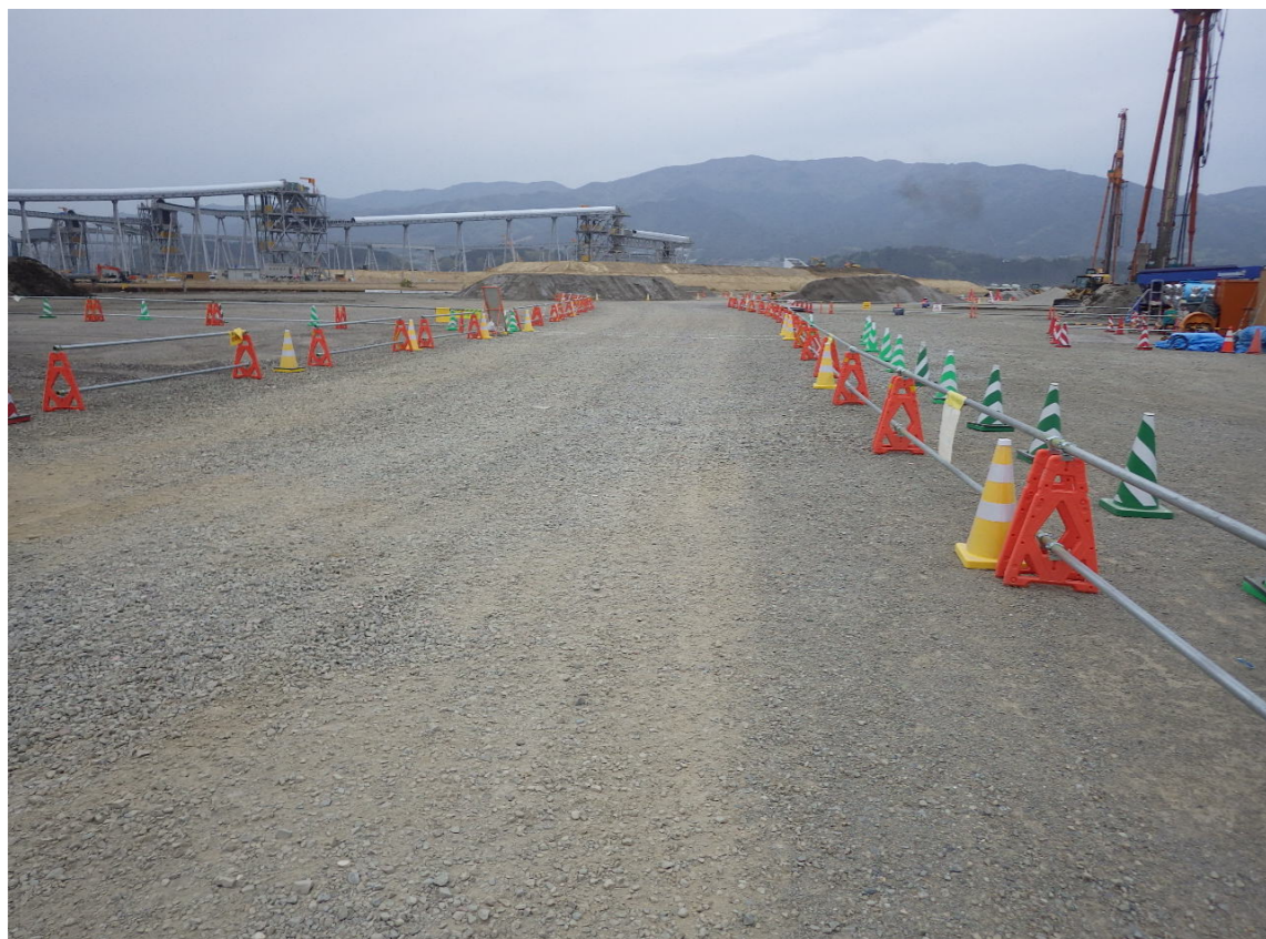
写真-1 重ダンプ走路および歩行者通路
