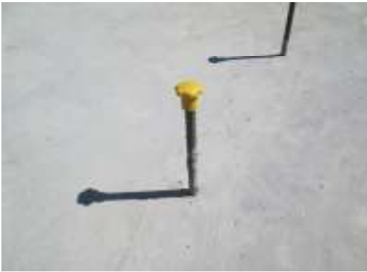
従来の鉄筋キャップ設置状況
