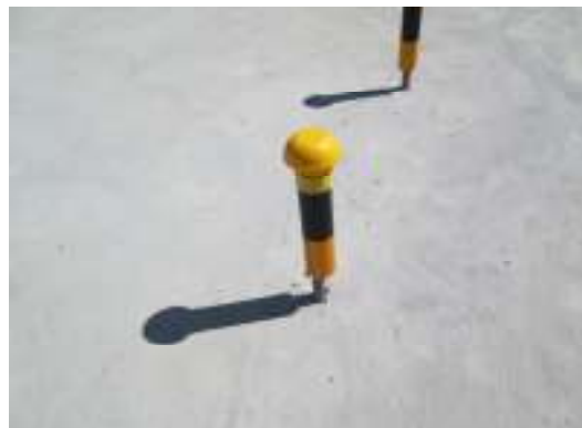
抜け落ちにくい鉄筋キャップ設置状況(トラ柄)
