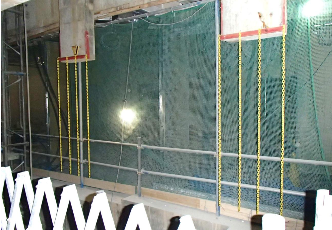
プラスチックチェーン設置状況
