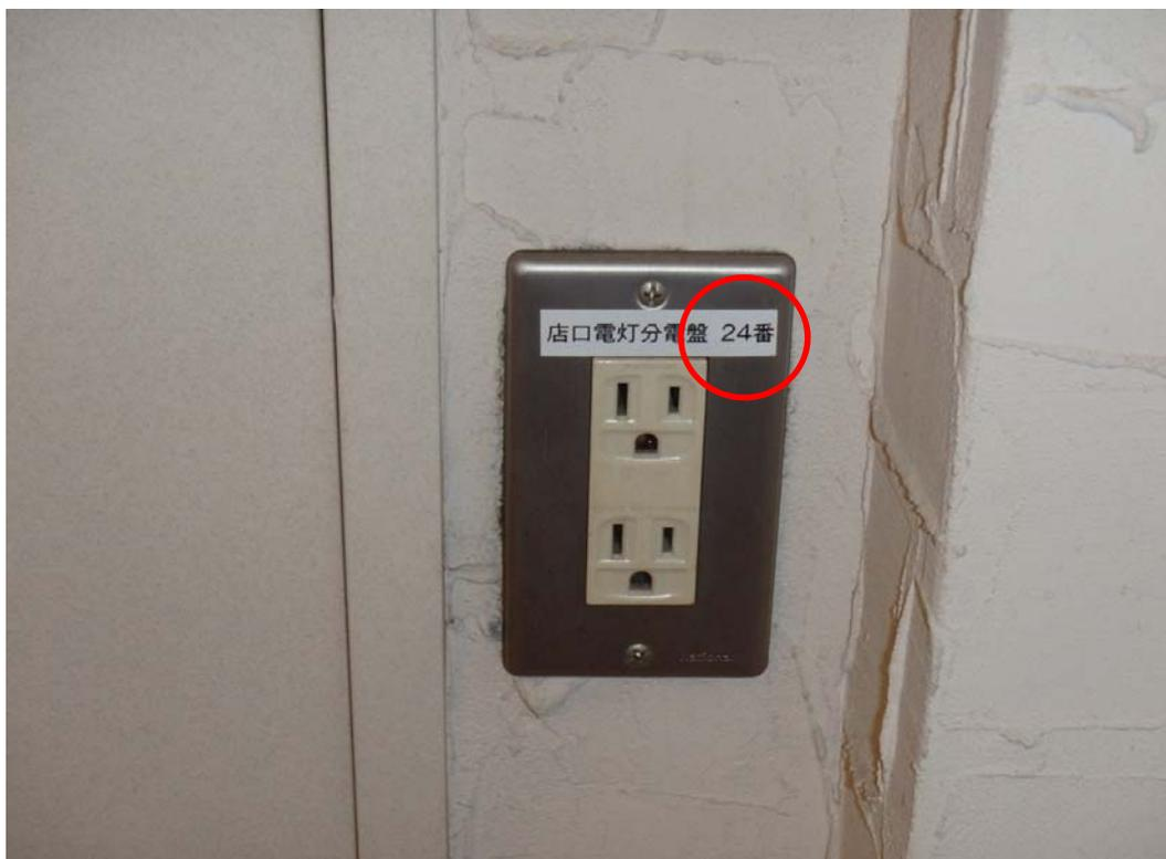
既存コンセントを複数使用する際、同じブレーカーの系統から電源を取った場合に過負荷となってしまう事を防止するため、コンセントに系統番号を貼り(赤丸印)、違う番号のコンセントを使用するように見える化した。
