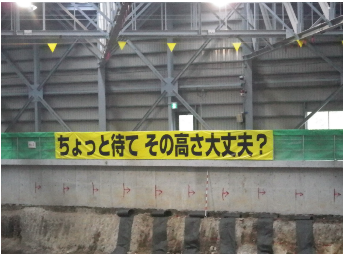
重機OPのすぐ目に着くように、縦1.2mの横断幕を設置
