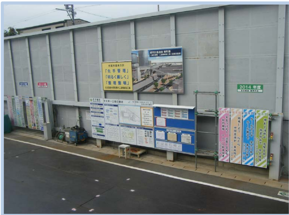
朝礼広場(安全標語看板掲示)全景
