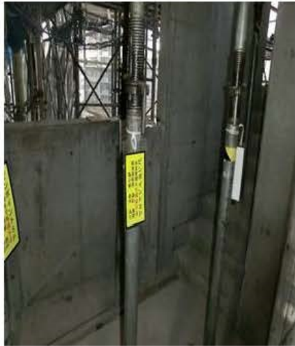
「型枠ピンポイント工法養生中」表示
