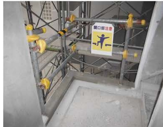
「足場と躯体とのすき間対策・開口部注意」表示
