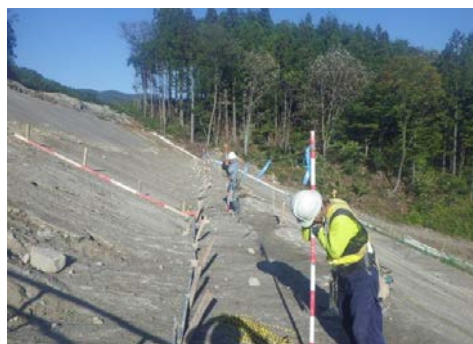
図-2 作業エリア明示ポールの設置
