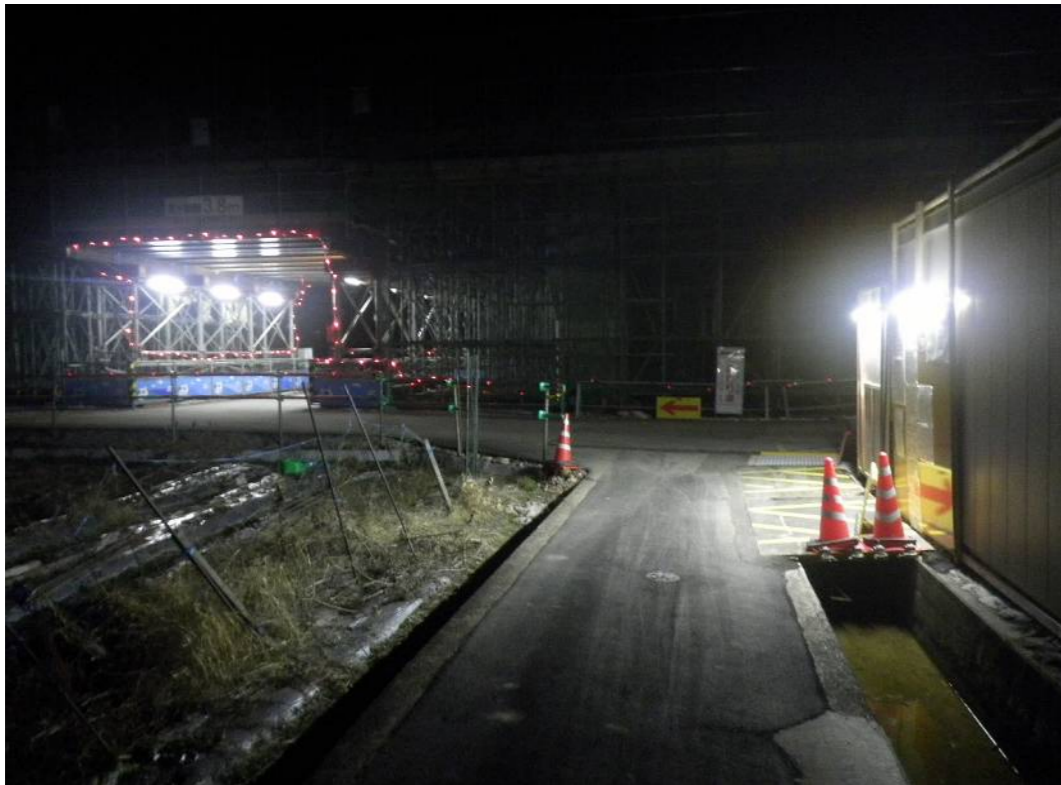
①道路通行帯に夜間照明を取付
