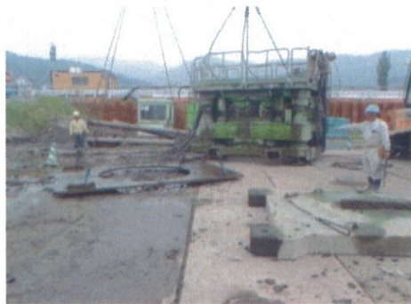
吊荷は30cm揚げて、3秒待つて、3m離れる『3・3・3運動』を実施
