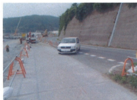
車両で護岸工へ行く場合、泊側から進入する
