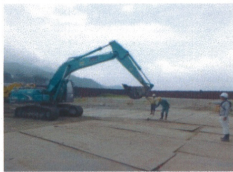
BHでの吊作業時には、クレーンモードへの切り替えと、監視員を配置
