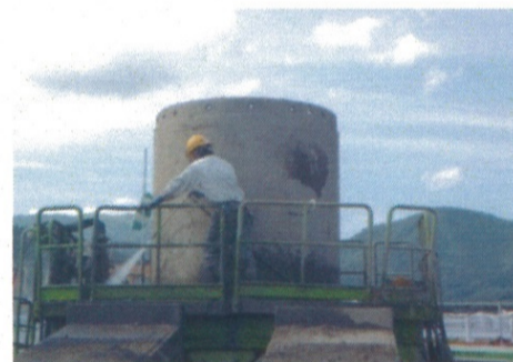
高所での作業時には安全帯を使用する
