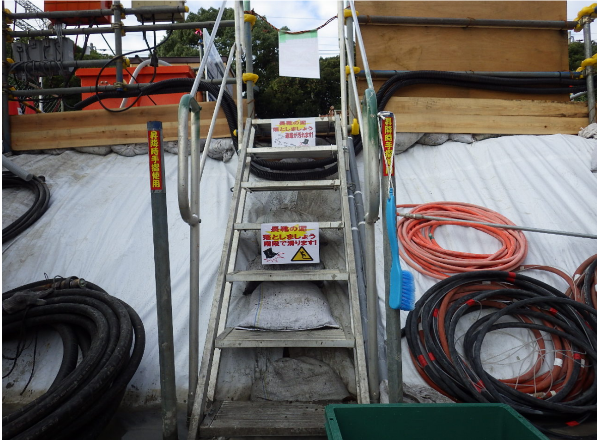
① 立坑出入口 階段全景
