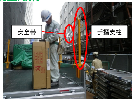
荷台上的手摺設置（落下対策）
