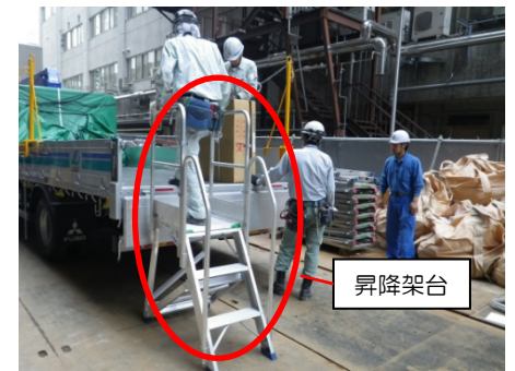
トラック専用昇降架台の設置
