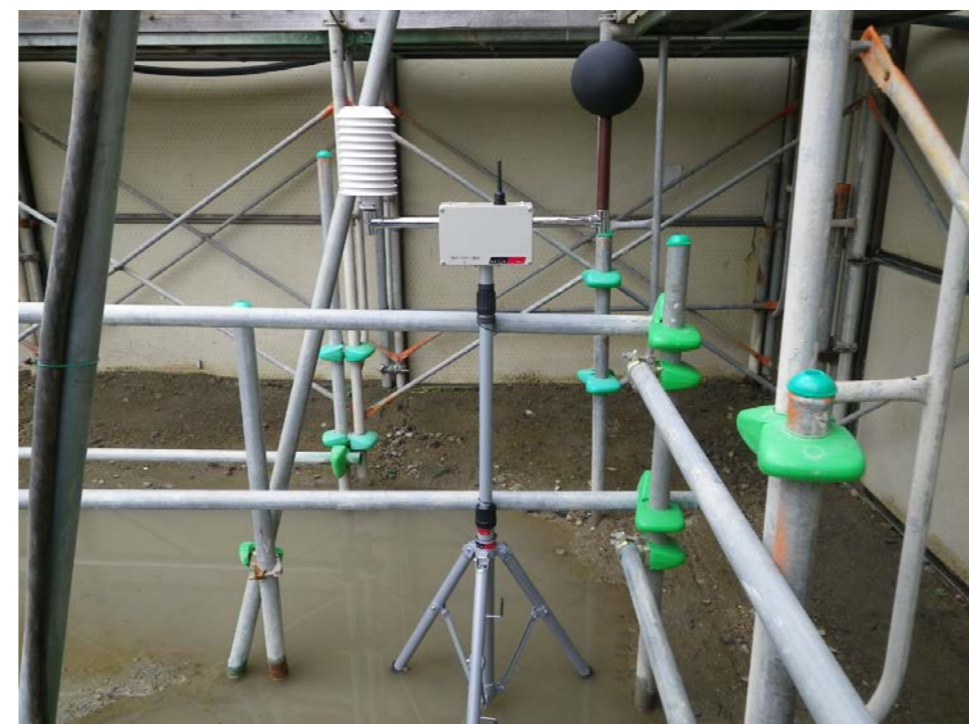
場内の作業等に支障しない部分に計測器を設置し、ここから掲示板の方に無線でデータを飛ばした。
