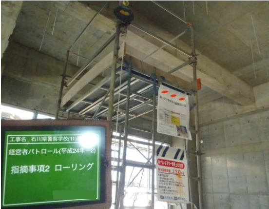
対象部位への看板設置
