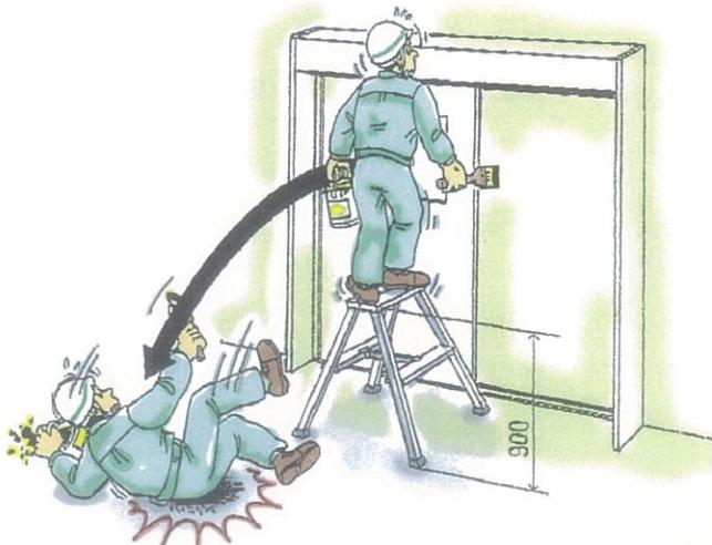
2 脚立上でリード線を引っ張った反動で後方のEV開口部より転落
