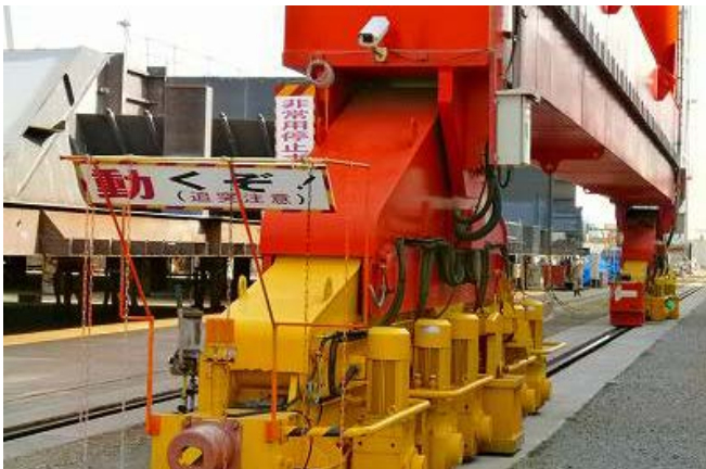
クレーンの足元、車両に「動くぞ！」表示
